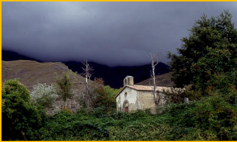
La Chiesa di San Martino , come appariva prima dei restauri.
